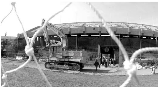
Γεφύρι της Αρτας έχει γίνει το νέο γηπέδο της ΑΕΚ στη Ν. Φιλαδέλφεια
