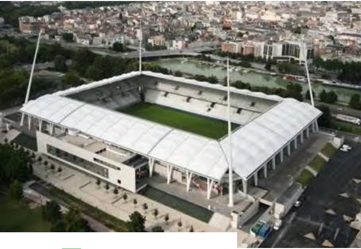
Стадіон «Реймс», форма даху якого пропускає світло на поле
